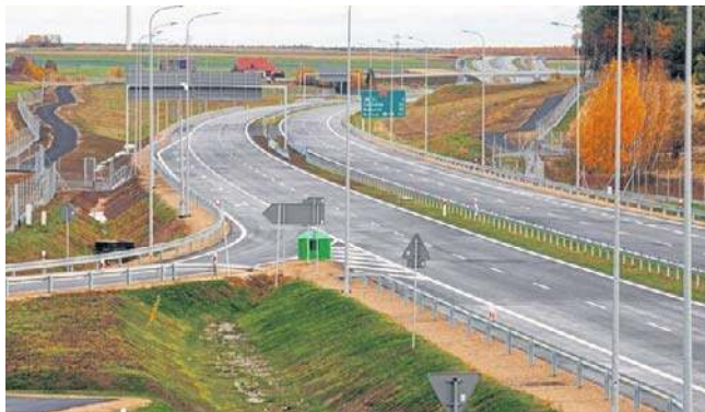
Od jutra kierowcy będą mogli korzystać z 21 km drogi ekspresowej między miejscowościami Haćki i Bocki
