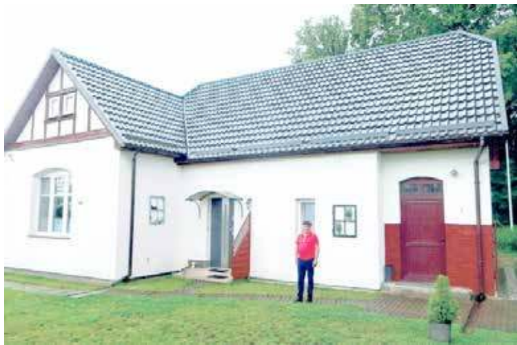
Budynek byłego dworca w Belcznej
