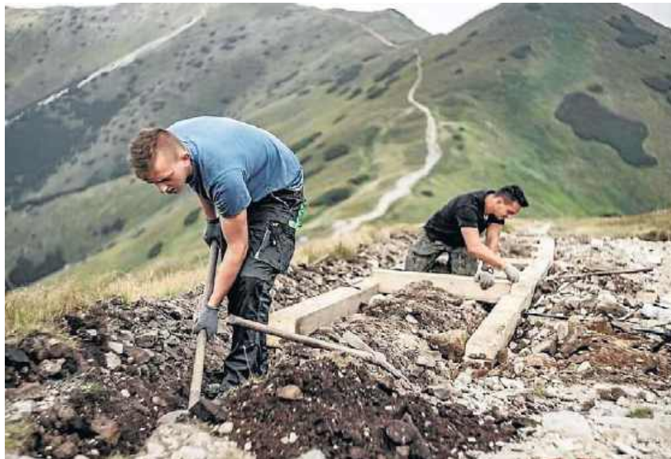
Remonty szlaków w Tatrach to ciężka robota. Większość prac wykonuje się ręcznie
