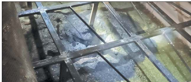
Po zakończeniu akcji gaśniczej obiekt sprawdzono kamerą termowizyjną – nie stwierdzono zagrożenia ponownego zapłonu.
