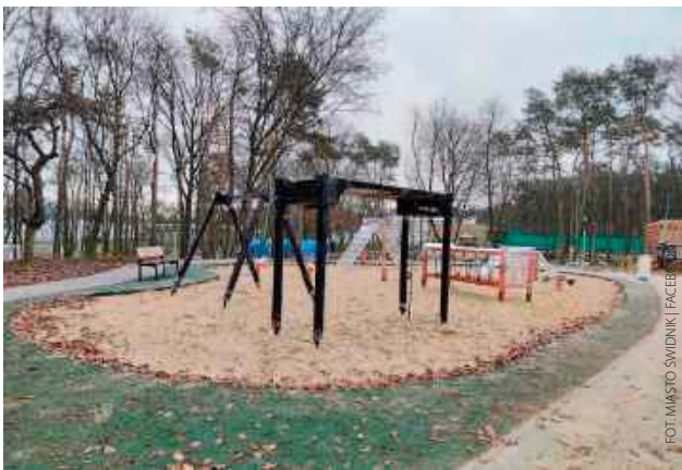
Prace przy budowie parku przy ul. Fabrycznej są na finiszu
