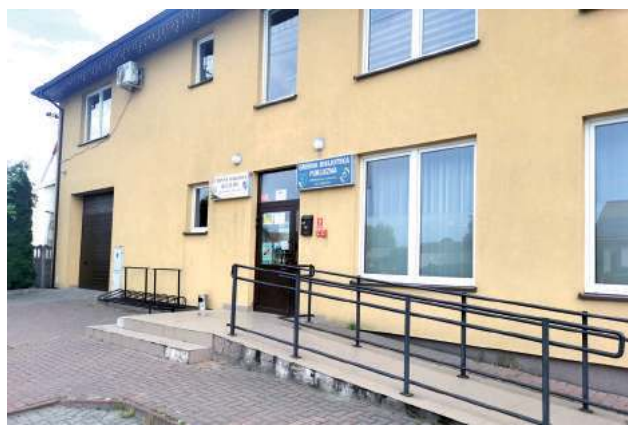
Na budynku Gminnego Ośrodka Kultury i Gminnej Biblioteki Publicznej już niedługo pojawi się instalacja fotowoltaiczna
