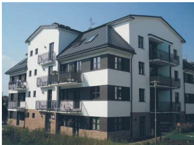
Wśród zgłoszonych obiektów w kategorii „Budynek wielorodzinny” znalazły się trzy z Koncertowej Doliny w Lublinie, których inwestorem i wykonawcą jest DomLublin. Przy ich budowie zastosowano następujące materiały Baumit: Baumit NivoFix, Baumit StarTex, Baumit SilikonColor i Baumit Lasur
