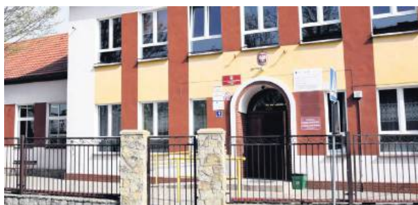
Szkoła Podstawowa w Prusach ma zamontowane ogrzewanie olejowe. Fot. SP Prusy
