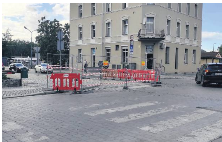
W ubiegłym tygodniu wymieniono przykanalik na skrzyżowaniu ulic Kolejowej i Bolka I Świdnickiego w Strzelinie
