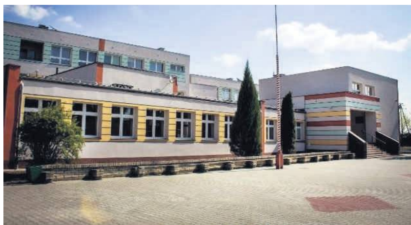
Szkoła Podstawowa w Borowie, tak jak pozostałe placówki w tej gminie, korzysta z ogrzewania olejowego
