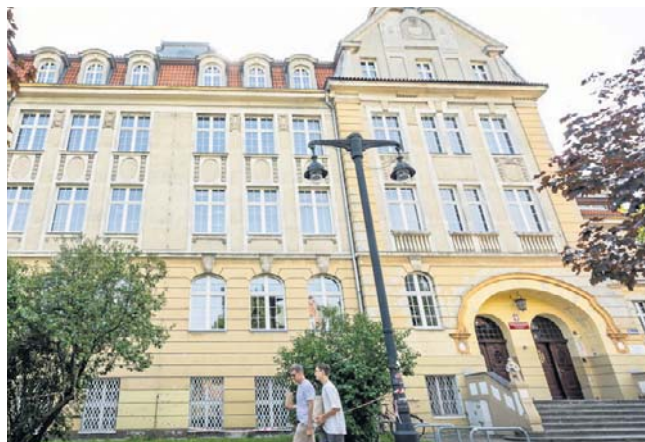
Budynek VI LO powstał w latach 1908 – 1910 z inicjatywy Rady Miejskiej w Bydgoszczy
