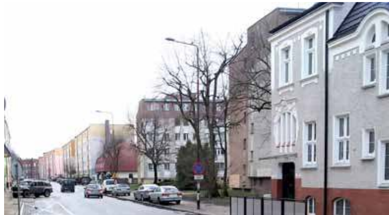
Przy ul. Krzywoustego wykonana zostanie nowa jezdnia, chodniki, przystanki, a także oświetlenie
