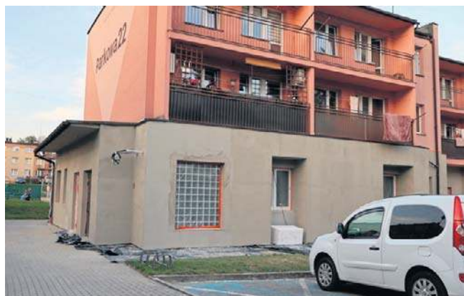
W Bieczu w jednym z bloków przy ulicy Parkowej, w pomieszczeniach po sklepie, powstają mieszkania
