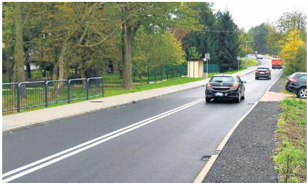
Wiele lat czekano na modernizację odcinka drogi powiatowej w Porębie Wielkiej
