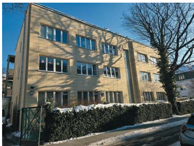
Fot. Biuro Stołecznego Konserwatora Zabytków
