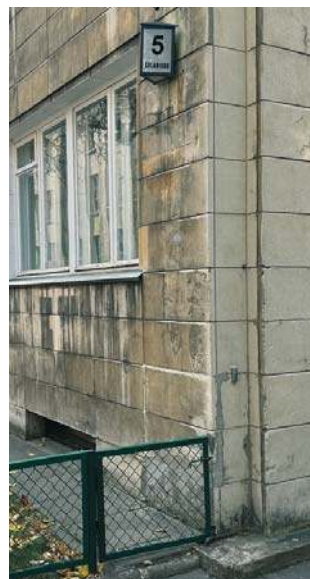
Fot. Biuro Stołecznego Konserwatora Zabytków
