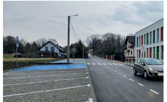
Wyremontowana ul. Dworska w Chrzanowie
