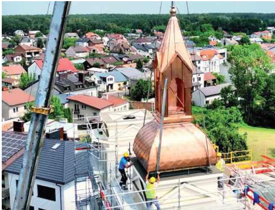
Do montowania kopuł sprowadzono specjalistyczny dźwąg
