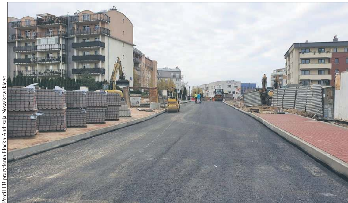
Na ulicach Chrostowskiej i Świtalskiej układane są pierwsze warstwy asfaltu
