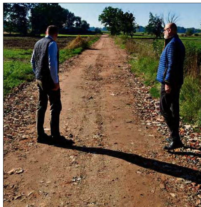
Polne drogi zostały utwardzone.
