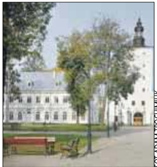
W Parku Radziwiłłowskim właśnie zakładany jest monitoring, a nad fosą powstanie kładka
