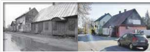
Przy ul. Kraszewskiego zachowały się budynki postawione lata temu, być może nawet przed wojną
