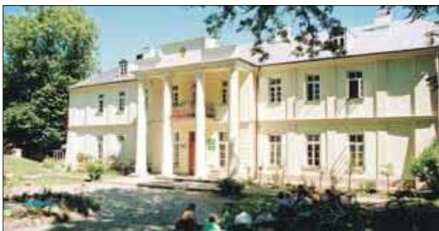
W parku Placencja mieści się już Dom Pomocy Społecznej (na zdj.), a w budynku dawnej oficyny powstanie izba pamięci i prawdopodobnie biblioteka oraz klub seniora
