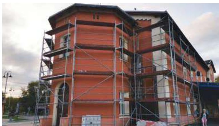
Remont elewacji potrwa do listopada
