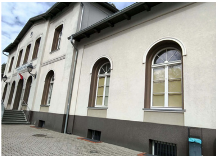
To właśnie przy stacji kolejowej w Brzegu Dolnym stało najwięcej hulajnóg.
