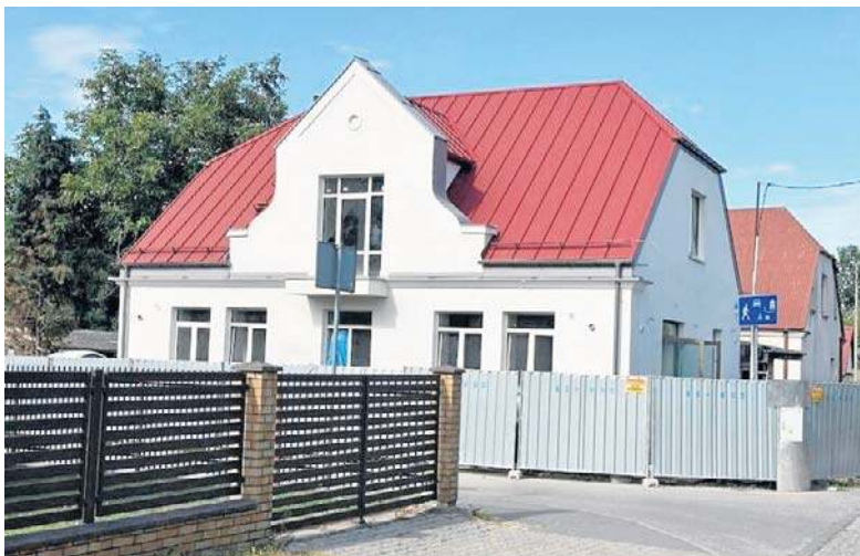
„Straszny dworek” przechodzi gruntowną modernizację.
