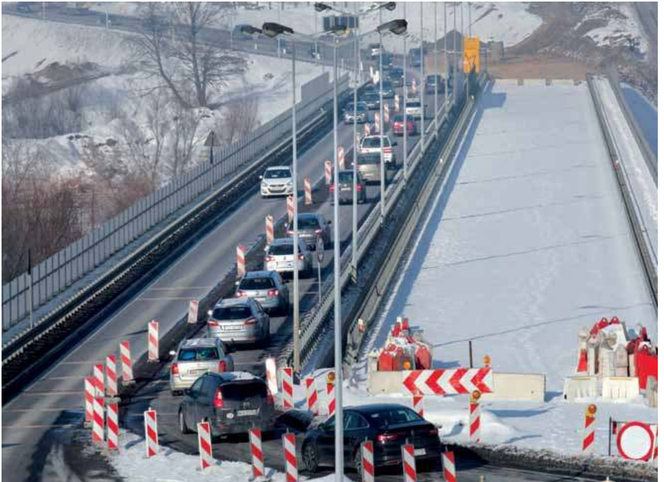
Przystanek autobusowy na wiadukcie zniknął z powierzchni ziemi.
