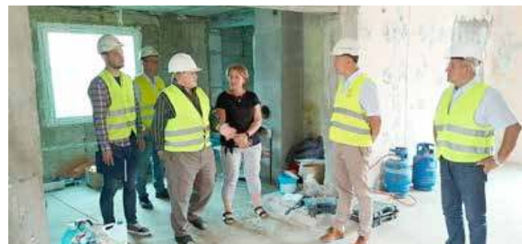
Jak zapewnił wykonawca robót na efekt prac przyjdzie poczekać najpóźniej do listopada
