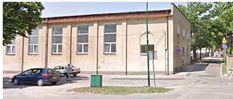
Dzięki pozyskaniu środków możliwy będzie remont dachu na sali I LO.png noksztalcącego im. ppor. Emilii Gierczak w Nowogardzie”.
