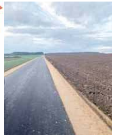
Fragment zmodernizowanej drogi Bogurzynek – Mdzewo
