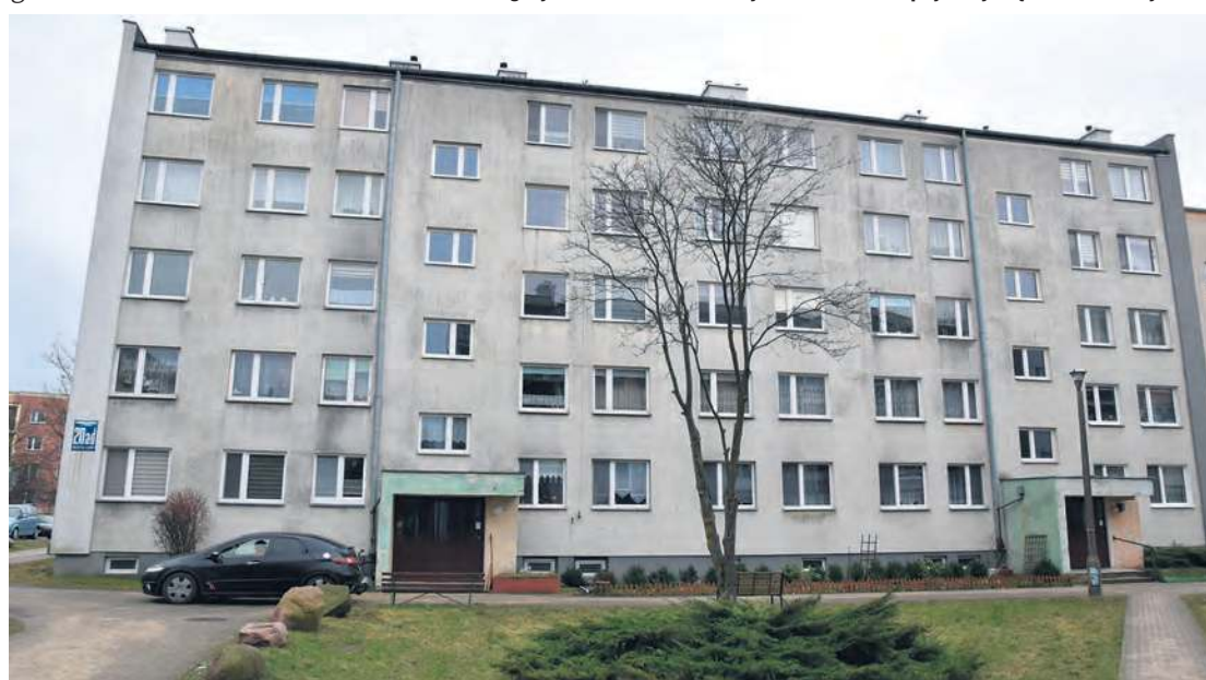
Na zdjęciu segmenty budynku a i b przy al. LOP 20, które czeka w tym roku remont dachu.
