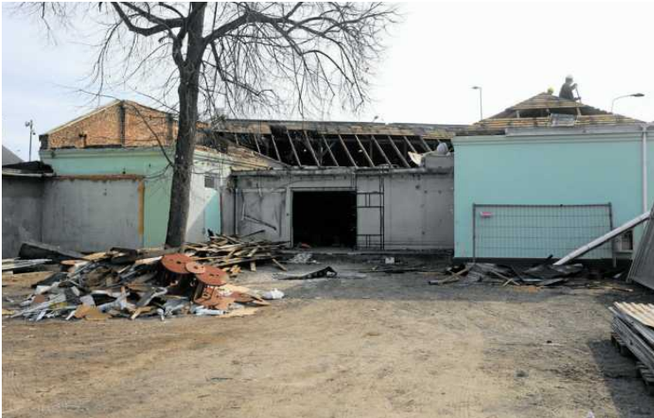
• Rozbiórka sklepu spożywczego w Radości FOT. JACEK MARCZEWSKI / AGENCJA WYBORCZA.PL
