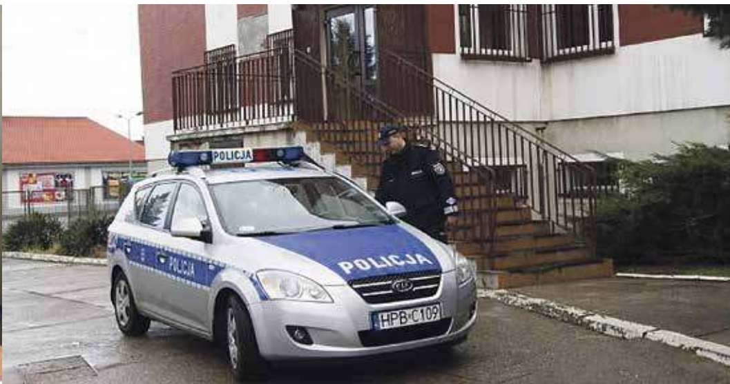
Komisariat tuż przed rozpoczęciem remontu
