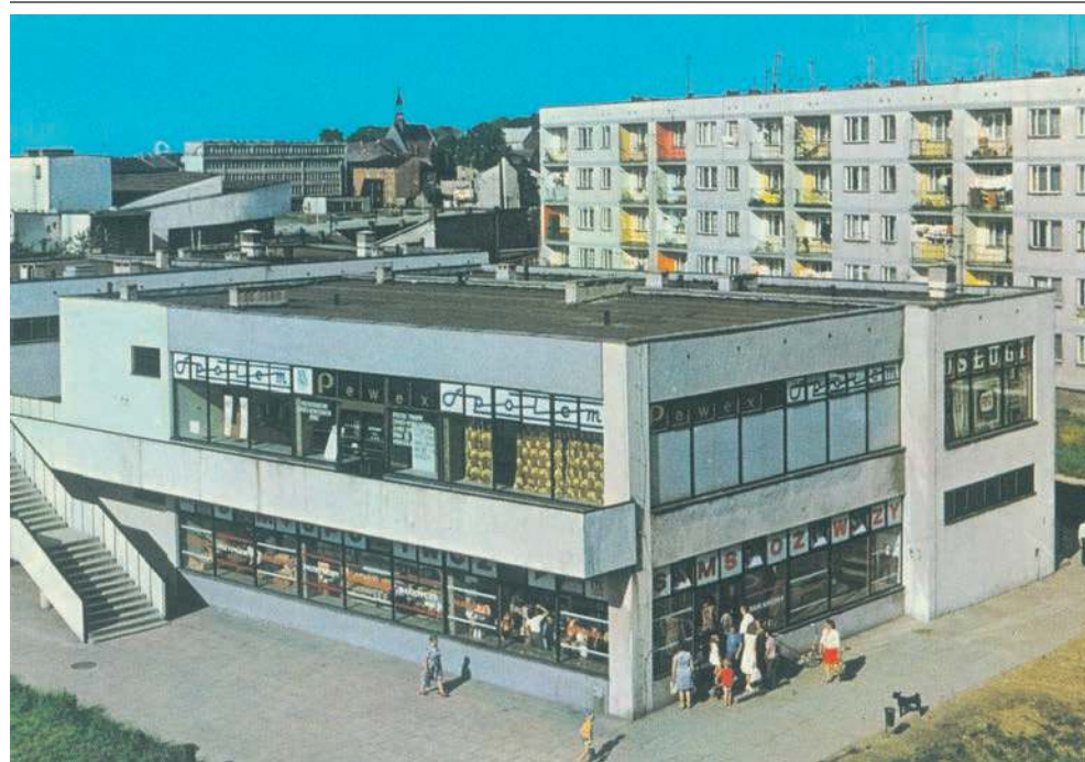
Wydawca podpisał widokówkę: Chrzanów. Fragment miasta. Na zdjęciu pawilon handlowy Wojewódzkiej Spółdzielni Spożywców „Społem” otwarty w 1972 roku. W 2008 na jego miejscu zaczęto budować bibliotekę ukończoną w 2010 roku. Autorem zdjęcia był Janusz Rosikoń
