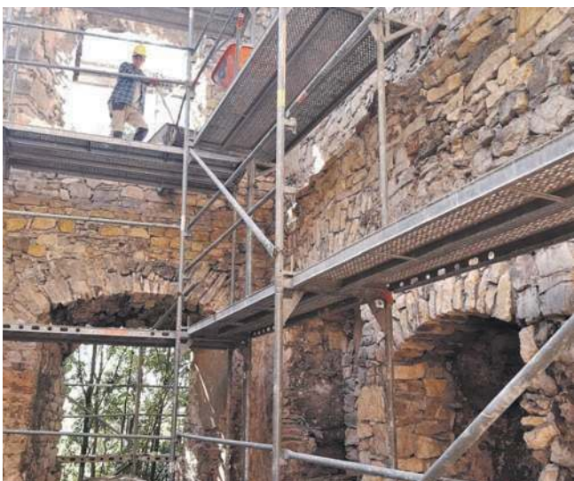
Na zamku Tenczyn prace idą pełną parą
