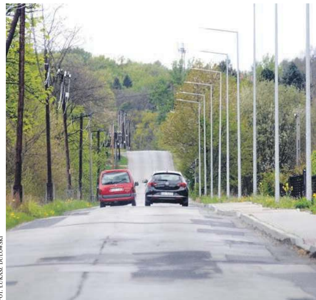
W październiku powinien rozpocząć się II etap modernizacji Krakowskiej w Alwerni
