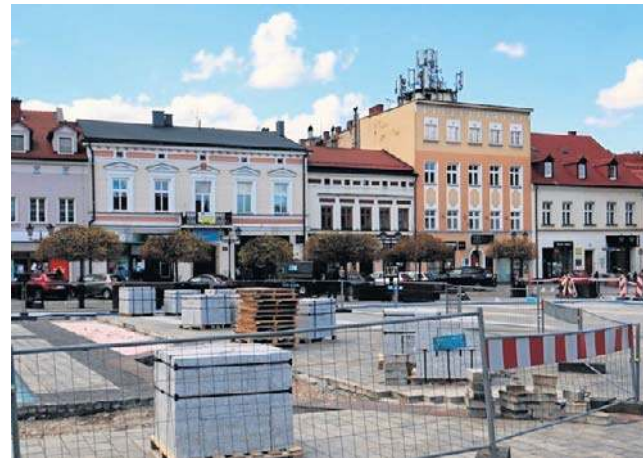
Rynek w Oświęcimiu przechodzi remont. Nie zmieni się jednak to, że wciąż będzie tu głównie beton
