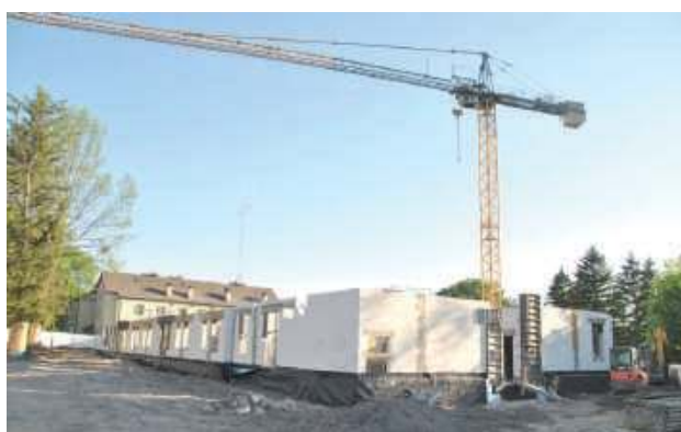
Fundamenty już są i ściany konstrukcyjne parteru. Prace związane z budową nowego pawilonu szpitalnego ruszyły z kopyta
