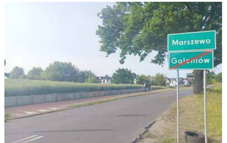
Droga w Marszewie jest rozbudowywana
