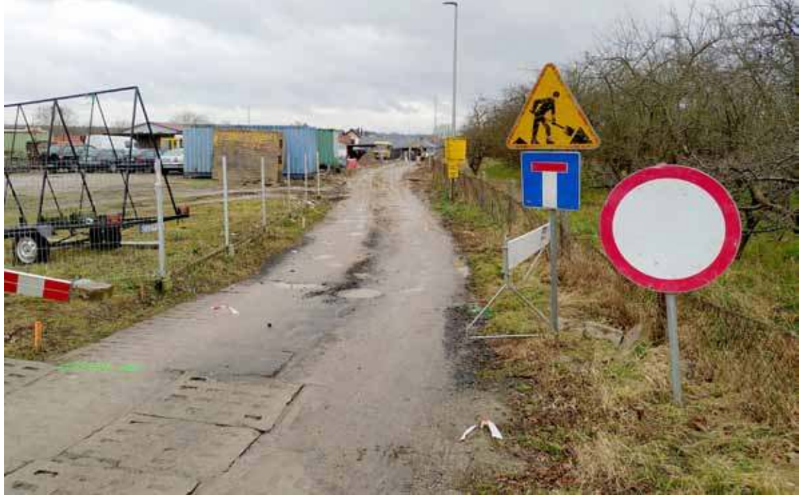
Jedna z nielicznych większych obecnie prowadzonych inwestycji to przebudowa ulicy Topolowej
