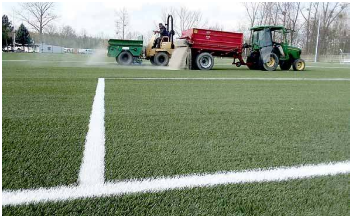
Zasypywanie murawy warstwą drobnego piasku
