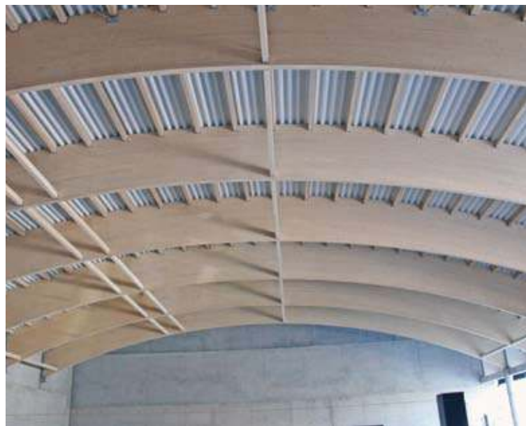
Trwają m.in. prace nad dachem
