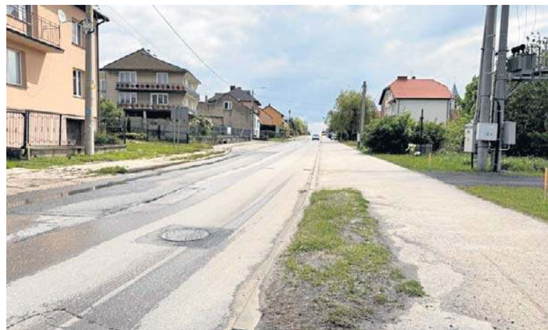
Duże utrudnienia na ulicy Sukowskiej. Drogowcy zamkną cały remontowany odcinek
