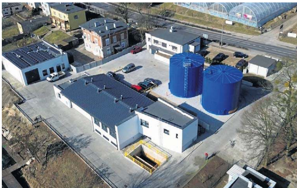
Na zdjęciu chełmżyńska stacja uzdatniania wody po zakończonej inwestycji ...
