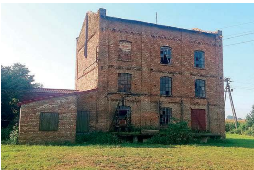
Budynek starego młyna w Baboszewie
