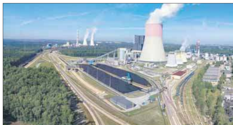
Prace na terenie bloku mogą wkrótce zostać wznowione
