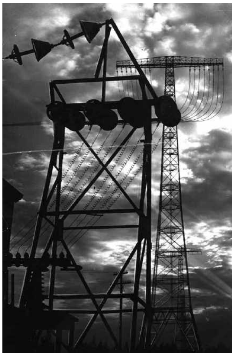
Fragment systemu antenowego z widocznymi urządzeniami do topienia szadzi
