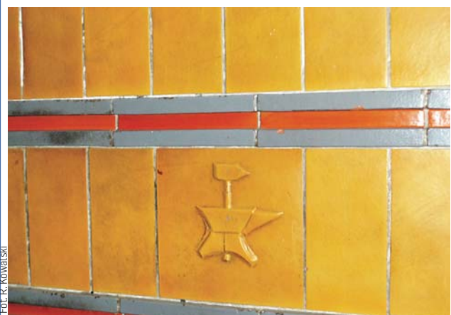
Fragment wewnętrznej ściany sieni ZSZ
