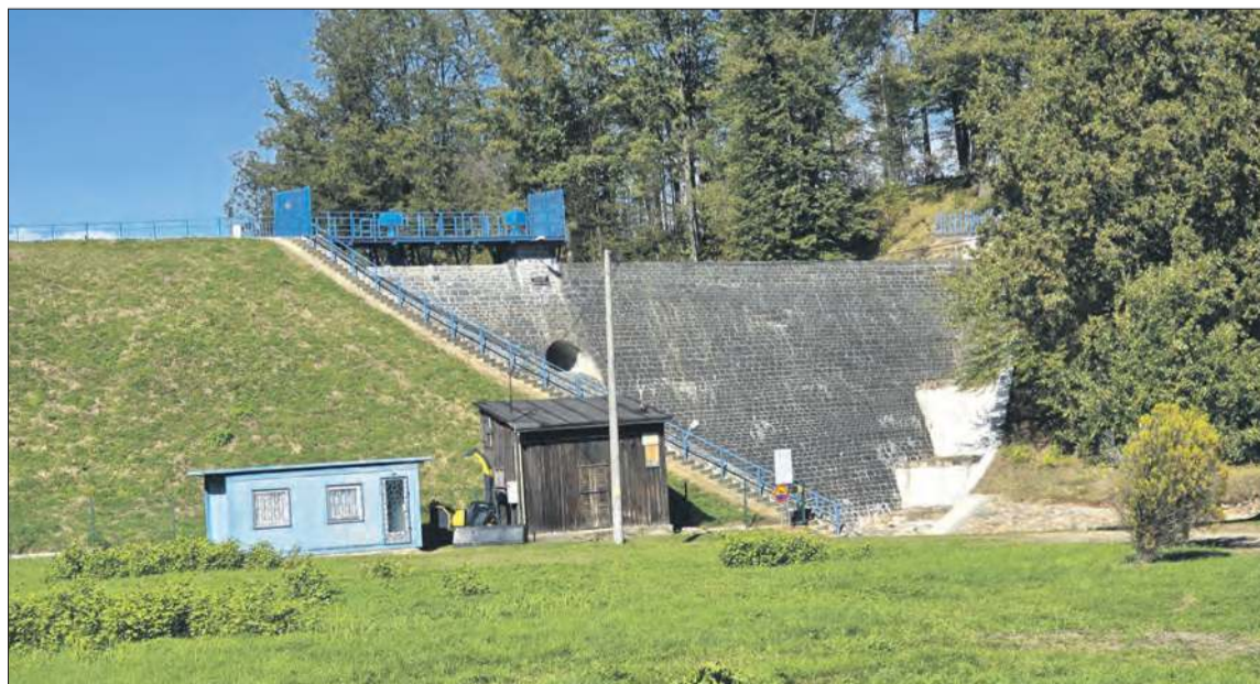
Wody Polskie planują wzmocnić ziemną część zaporę w Jarnołówku
