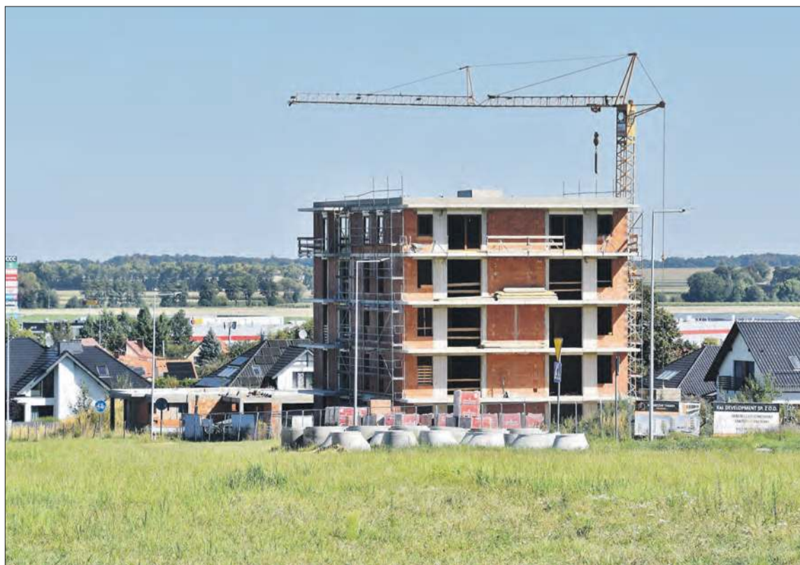
Budownictwo mieszkaniowe hamuje, ale nie eliminuje negatywnych procesów demograficznych. Na fotografii budowa bloku przy ul. Fränkla w Prudniku
