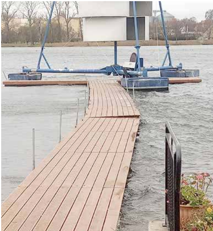
Aerator uszkodził pomost w dwóch miejscach, więc teraz konieczne będzie podjęcie napraw
