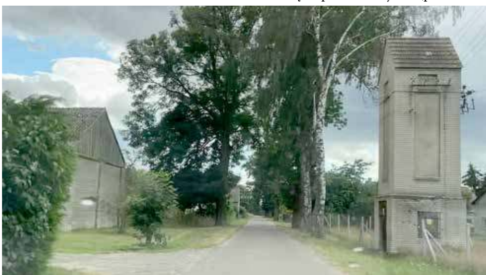
Ciekawą budowlą w wielu wsiach są murowane „domki” trafostacji
