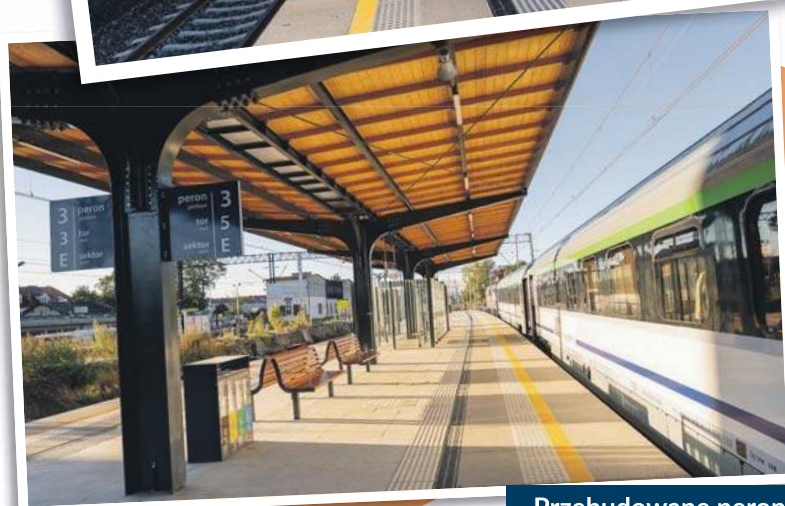
Przebudowane perony na stacji Słupsk
