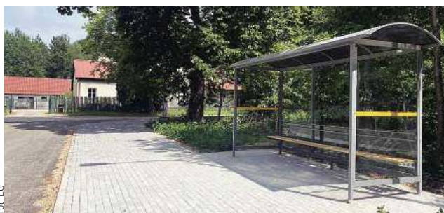
Wzdłuż nowej ulicy zainstalowano trzy wiaty przystankowe
