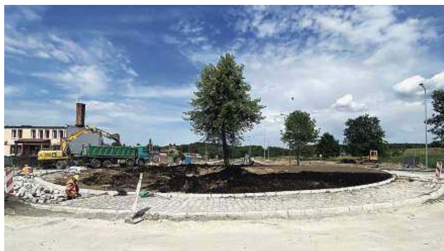
Trwa budowa ronda przy Łęczyckiej
