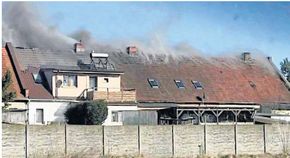
Pożar poddasza budynku wielorodzinnego w Ćmachowie zniszczył sześć mieszkań. Około 20 osób straciło dach nad głową
