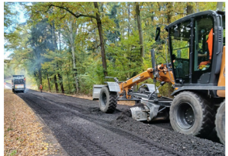
Modernizacja drogi powiatowej nr 1284D Wołów-Gródek.
