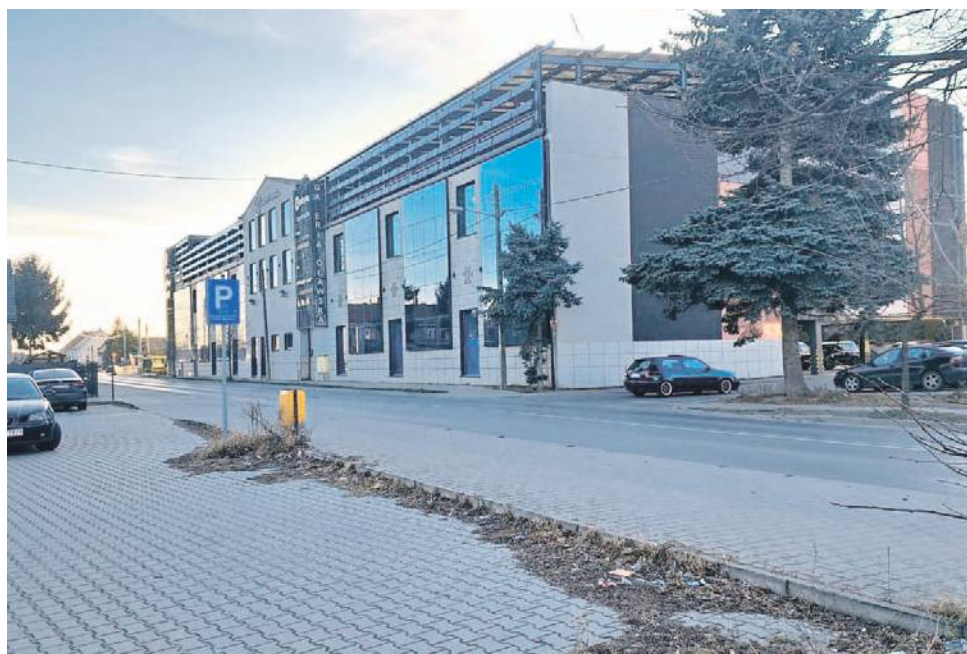
Tu będzie nowe przejście dla pieszych
