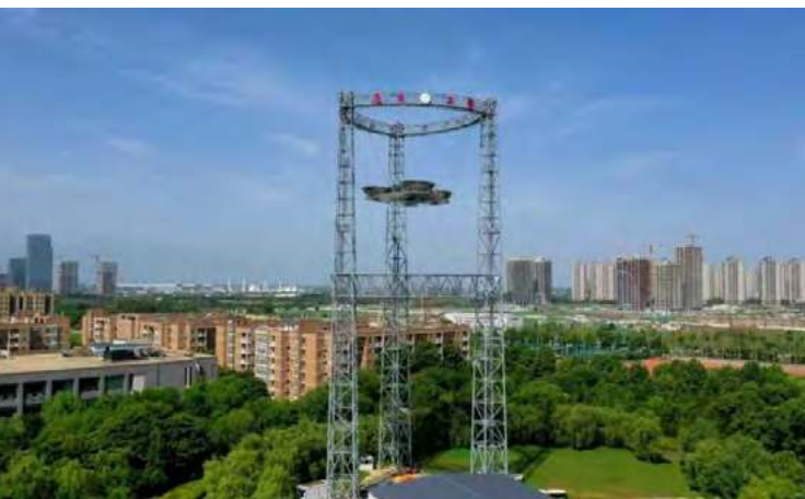
Fotografia 3. Konstrukcja stalowa o wysokości 75 m, w której znajdują się systemy do testowania kosmicznej energii słonecznej, na Uniwersytecie Xidian w Xi'an w północnych Chinach.
