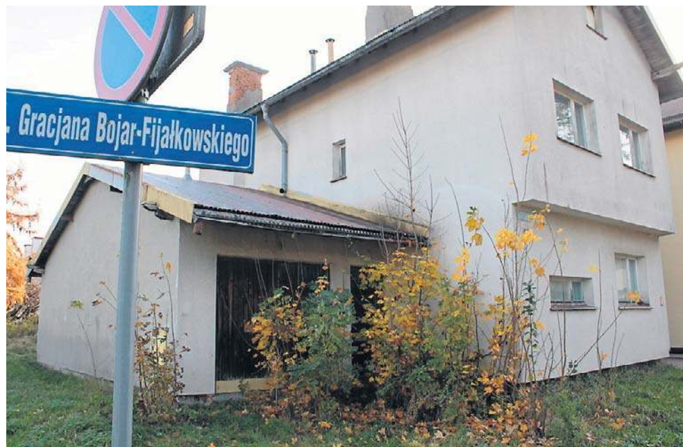
- Obiekt otrzymaliśmy w spadku już prawie 2 lata temu - mówi prezydent Koszalina
