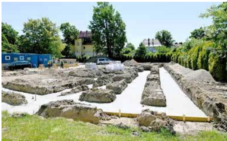
Wykonawca wszedł na plac budowy w kwietniu. Zrealizowano już część robót związanych z kanalizacją deszczową oraz sanitarną
