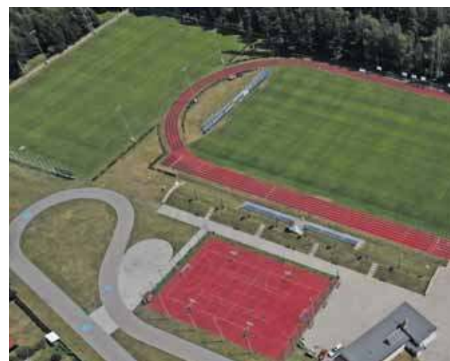
Zakres prac obejmuje szereg inwestycji, które mają zwiększyć funkcjonalność obiektu przy ul. Fabrycznej w Kaletach
