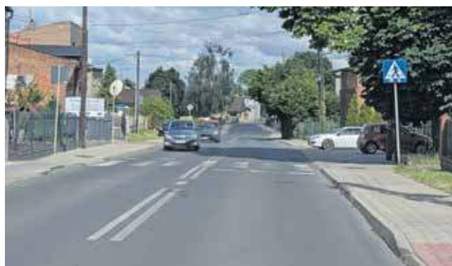
Zmodernizowany zostanie m.in. przejście w Bobrownikach
