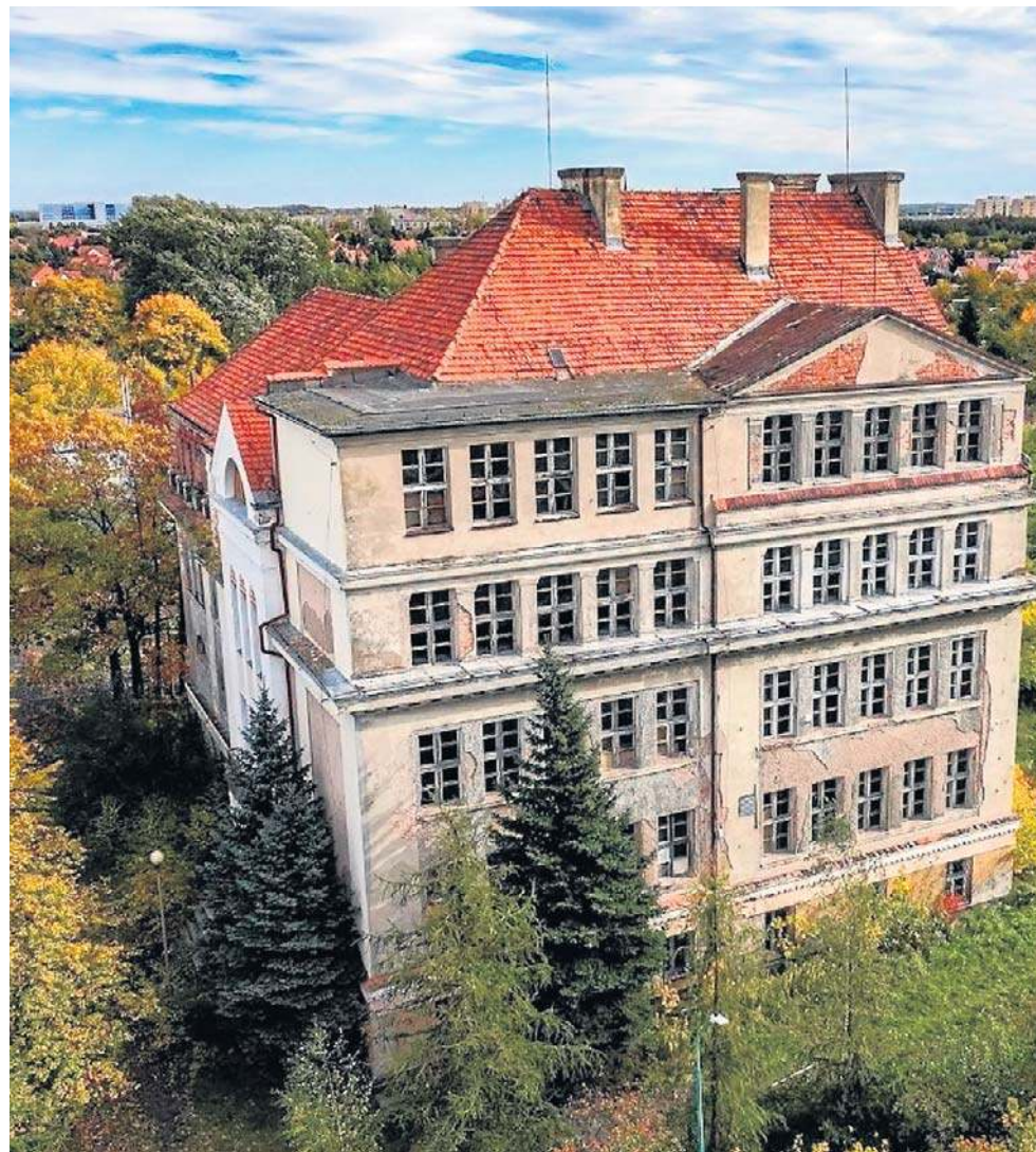
Budynek dawnej szkoły jest sporych rozmiarów. Liczy cztery piętra i jest częściowo podpiwniczony. Powierzchnia użytkowa to niewiele ponad 2 tys. metrów kwadratowych
