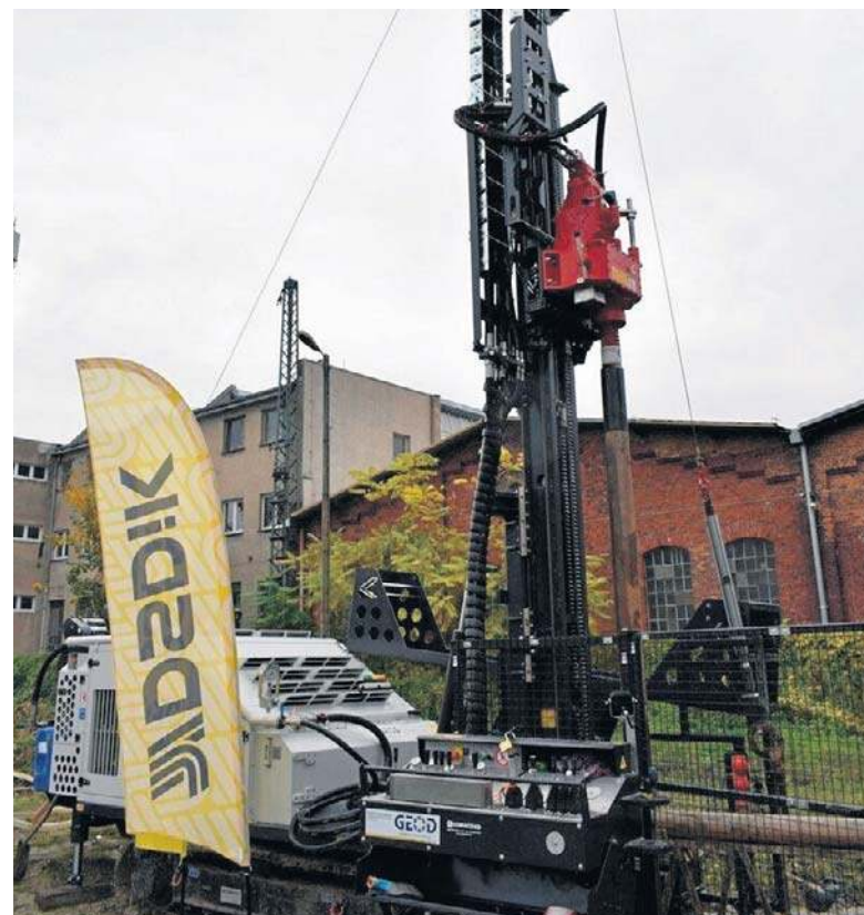
Koło Świebodzkiego zaplanowano dwa odwierty o głębokości 30 m
