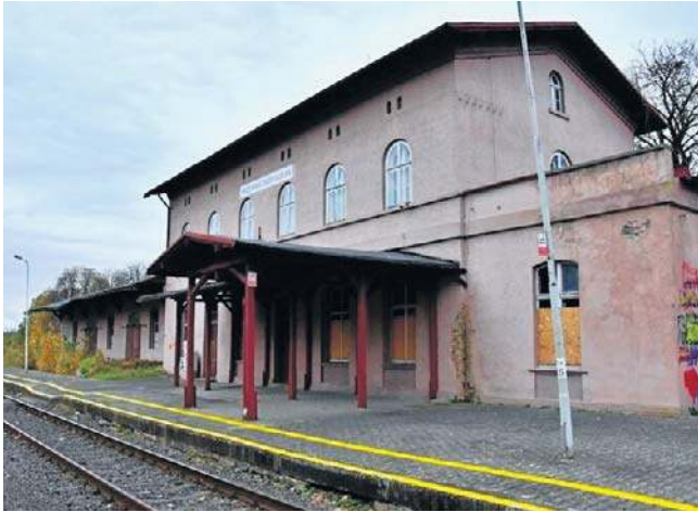
Budynek stacyjny nie jest już wykorzystywany do obsługi ruchu kolejowego
