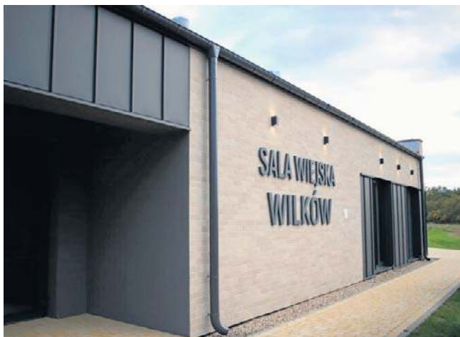
Zmodernizowano także boiska oraz miejscową remizę Ochotniczej Straży Pożarnej
